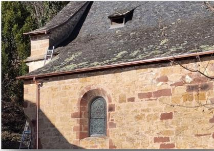
Il a été constaté un taux d'humidité très important dans l'église, de par sa situation enterrée et suite au Plan d'Aménagement du Bourg qui a détérioré cette situation. En effet, le drain longeant l'église côté nord a été supprimé et remplacé par des prises d'évacuation d'eau en prévision de pose de gouttières, qui n'ont pas été posées. Seules quelques gouttières en cuivre côté sud existaient.
