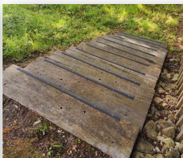
Pose de bandes anti-dérapantes sur les marches extérieures
