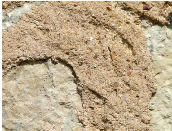
Enduit rosé, granuleux, rustique, plein de graviers et de petites pierres, éclatant ou terni
