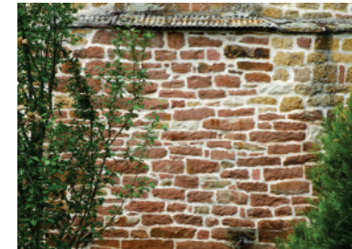
Façade jointoyée, en creux, en trop clair (non) avec effet de pixellisation de la surface
