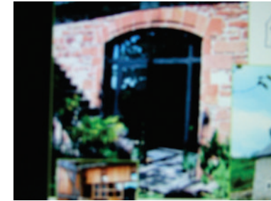
Photo CAUE: le châssis foncé disparaît dans le vitrage
