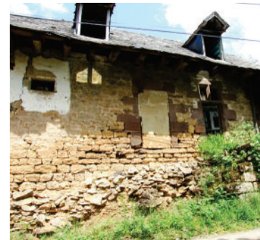
Enduit et badigeon à Sabazot
