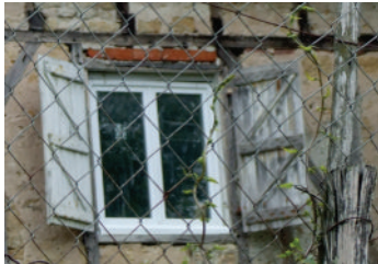
Partition visible du fait de la couleur trop claire des châssis
