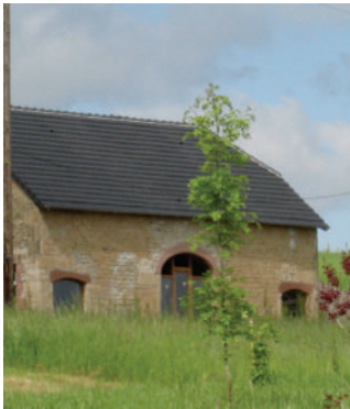
Photos à distance, qui montrent les percements traditionnels: portes, fenêtres, contrevents et la grande surface des portails.
