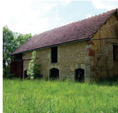
Photos à distance, qui montrent les percements traditionnels: portes, fenêtres, contrevents et la grande surface des portails.
