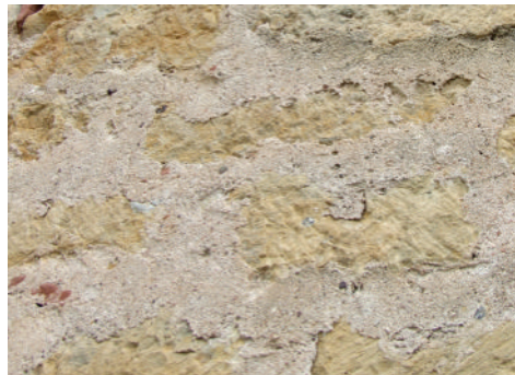
Enduit rosé, devenu « enduit à pierres vues » par usure.
