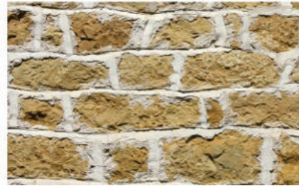
Façade jointoyée, en creux, en trop clair (non) avec effet de pixellisation de la surface
