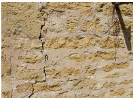
Enduit rosé, devenu « enduit à pierres vues » par usure.
