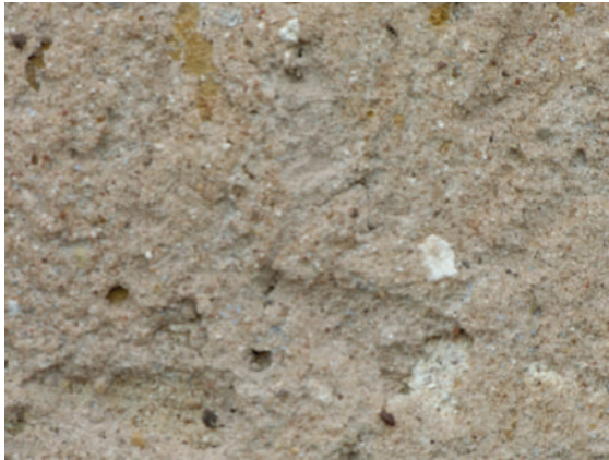
Enduit rosé, granuleux, rustique, plein de graviers et de petites pierres, éclatant ou terni
