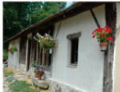
Oui : Ferme landaise réhabilitée: le châssis noir invisible/vitrage, conserve l'ouverture d'antan -
