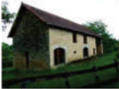
Ferme à Ligneyrac
