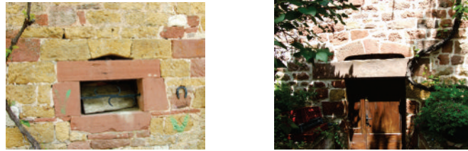
2 linteaux soulagés par un arc de décharge à Peyrignac
