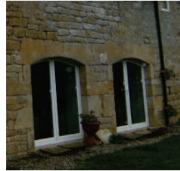
Partition visible du fait de la couleur trop claire des châssis
