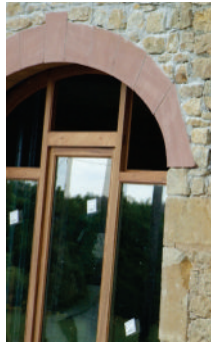
Partition visible du fait de la couleur trop claire des châssis
