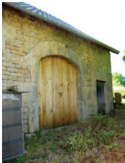
Les portails encore en place aujourd'hui, sont en bois et s'ouvrent vers l'intérieur du bâtiment :
