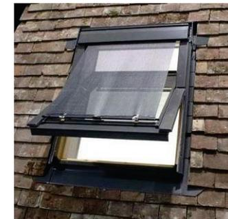
Exemple mal intégré à proscrire de châssis posé en saillie compris coffret de volet d'occultation extérieur
