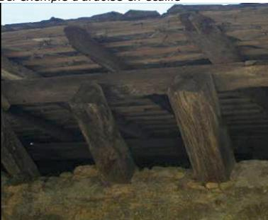
Le traitement des débords de toit varie en fonction des époques de construction et du matériau de couverture mis en œuvre : ici une maison du XV<sup>e</sup> siècle qui conserve un de débord de toit très marqué supportés par des abouts de solives sur lesquels s'appuie, par l'intermédiaire d'une panne, les chevrons
